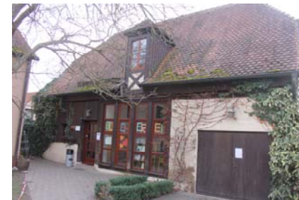
Gemeindehaus (vormals Pfarrscheune)
